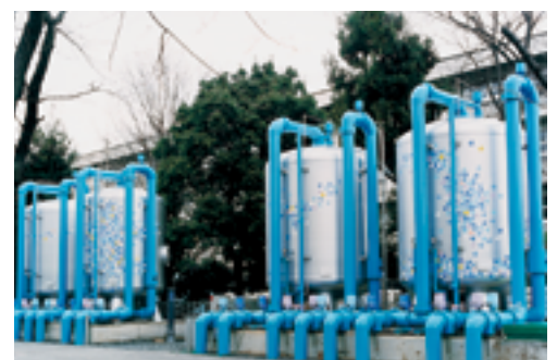
浄水場濾過槽
